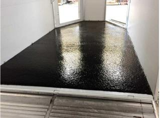
Divises le mélange directement sur le plancher et répands avec une spatule ou un râteau. Avec un rouleau avec des épines (sous une légère pression) les pores sont fermés et il peut en outre être lissées en détail. L'intensité de rouler détermine la finesse finale – la rugosité de la surface.
