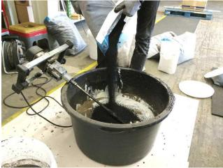
Ajout le caoutchouc dans le mortier et bien mélanger. réserves 2-3 kilo. Si le mélange est trop mince on peut ajouter les 20u 3 kilos de caoutchouc en réserve.
