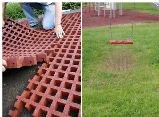
Placez-les sur une surface suffisamment stabilisé à structure ouverte. Remplir avec substrat drainant approprié pour dalles gazon et semer du gazon. Prend en service après l'herbe a développé.
